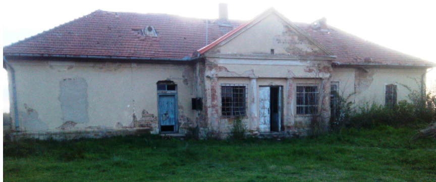
Az iskolaépület láthatóan felújításra szorul
